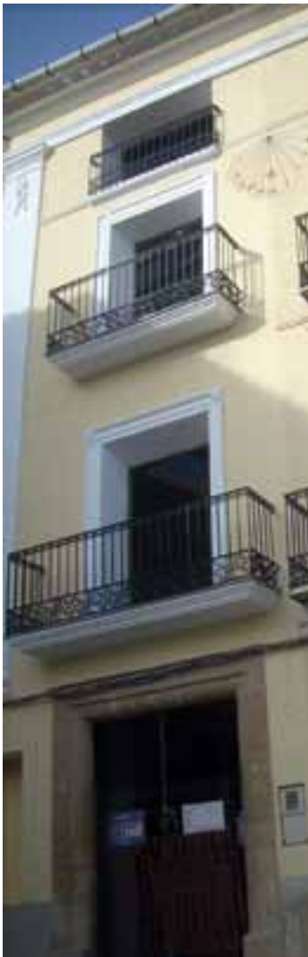
Fachada ya restaurada del actual edificio de Pensionistas y Jubilados.
